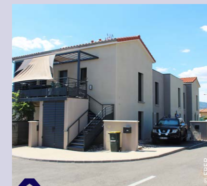
12 nouveaux logements sociaux livrés à Saint-Clair-du-Rhône. Réalisation Habitat Dauphinois, subventionnée par EBER.
