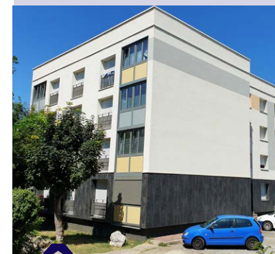
Immeuble situé aux Ayencins à Roussillon, qui a fait l'objet de travaux de rénovation énergétique avec une intervention sur l'isolation et le changement des menuiseries. Réalisation Alpes Isère Habitat, subventionnée par EBER.
