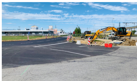
Travaux rue Denis Papin
