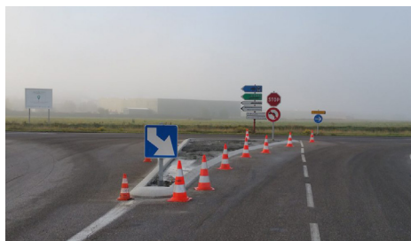
Travaux de sécurisation de la RD51
