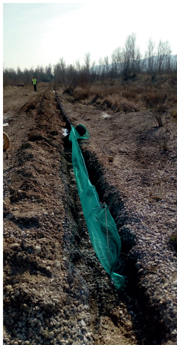
Déploiement des filets de protection autour de la future implantation de Rhonaport.
