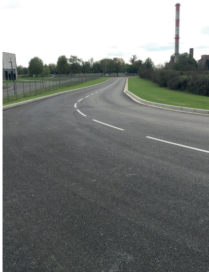
Travaux réalisés sur le lot B
