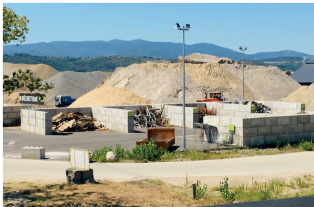
Vue d'ensemble sur la nouvelle déchetterie professionnelle Valorsol Environnement
