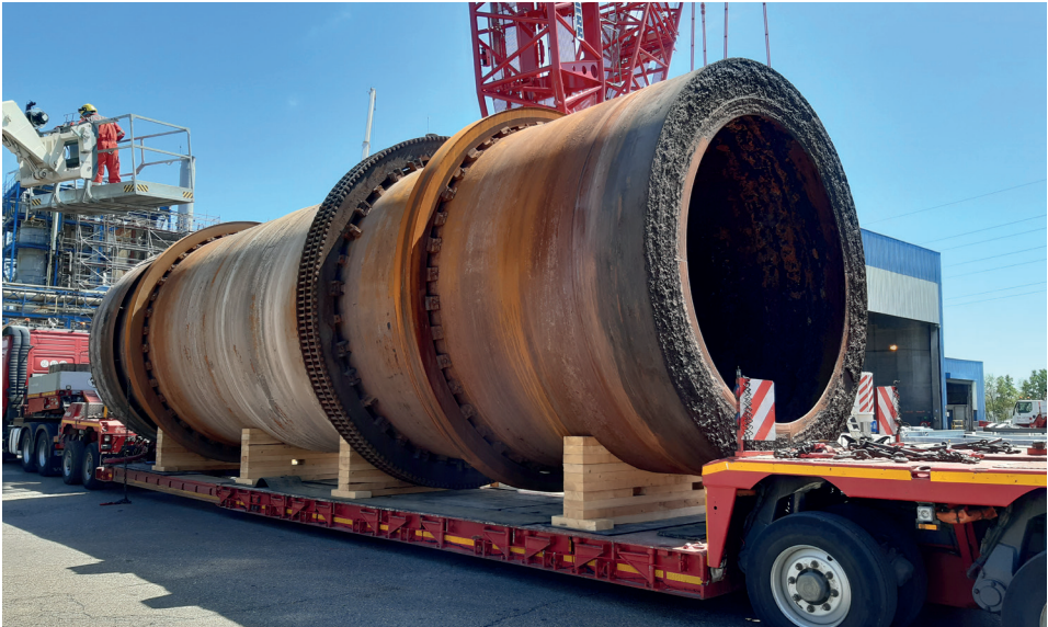
Travaux sur l'Unité 2 de Trédi Salaise
