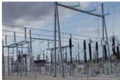
Le nouveau poste électrique Denis Papin
