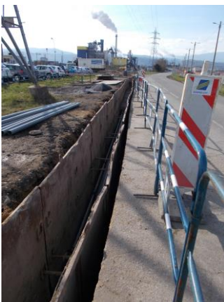
Enfouissement de la ligne électrique - rue Denis Papin Source syndicat mixte ZIP Salaise-Sablons
