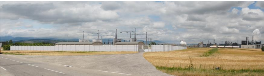
Vue du futur poste de transformation électrique -source RTE-ERDF
